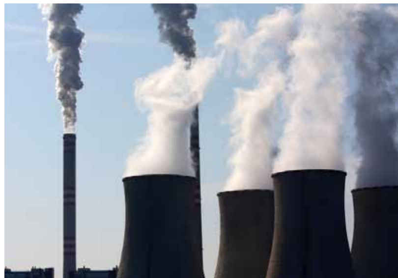
Central térmica de carbón de producción eléctrica
